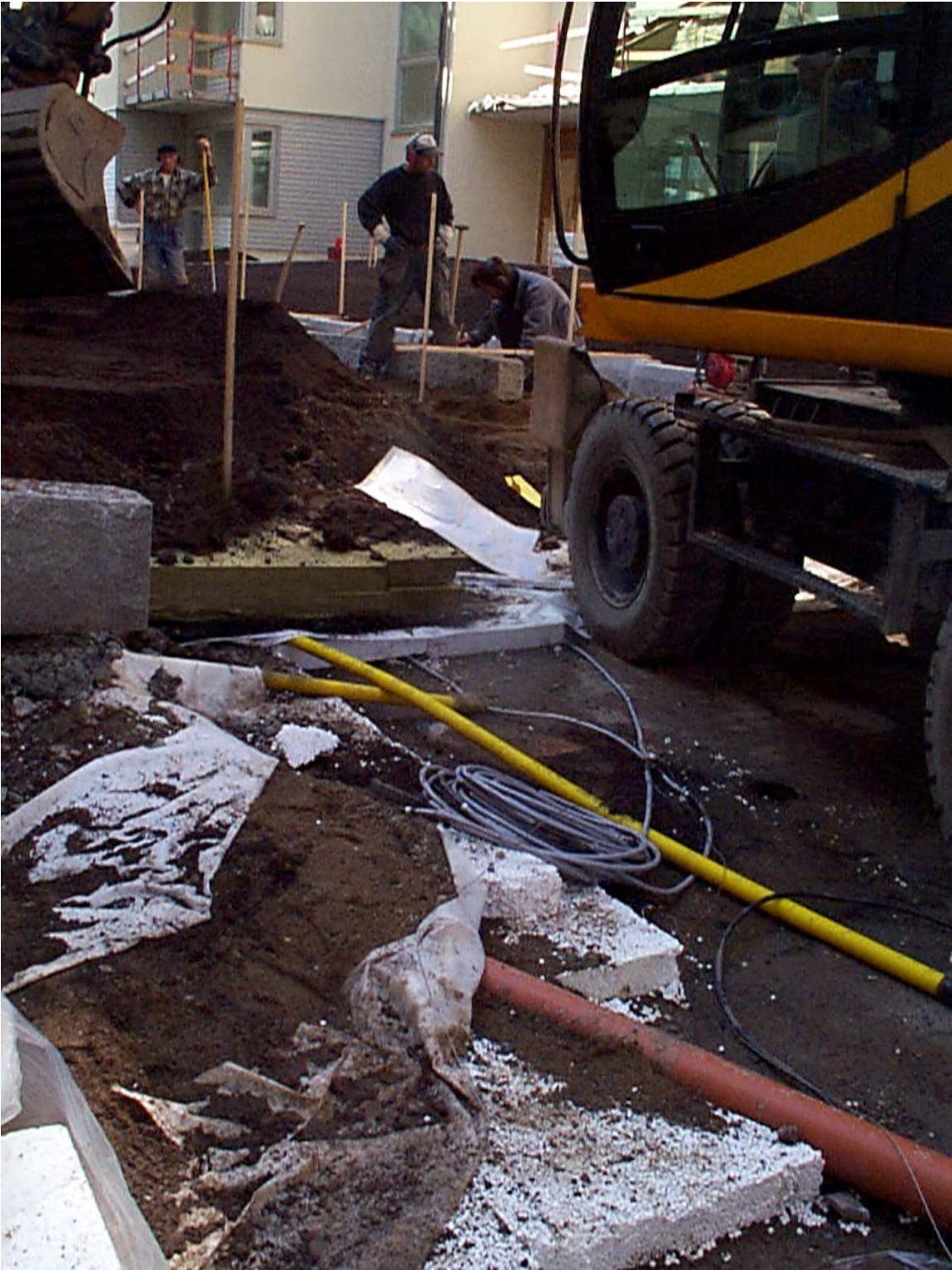
Figur 8 Delar av terrassen färdigställs medan läcksökningssystemet det på andra delar av terrassen ännu inte är färdigt installerat.
