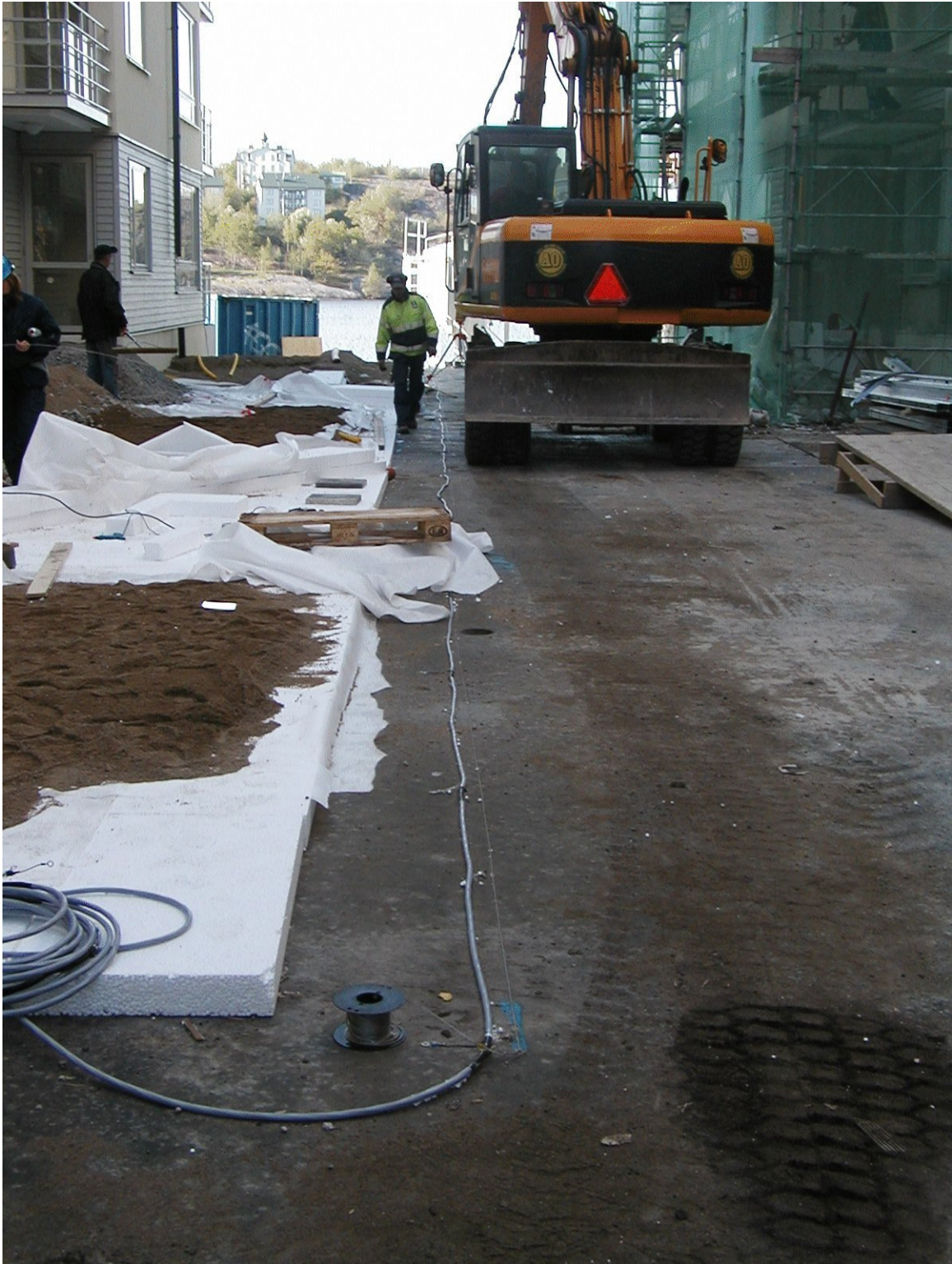
Figur 5 Vy mot söder med kablarna placerade ovanpå terrassens tätskikt.
