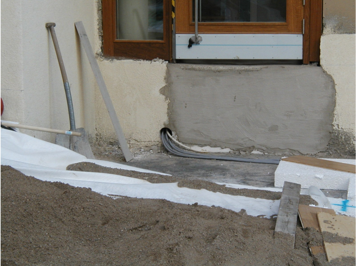
Figur 7 Bild på kablarna när de går in i huset.
