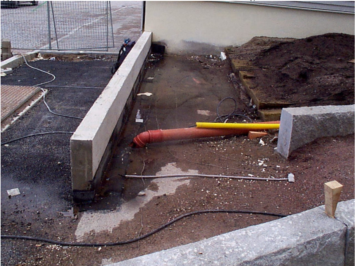
Figur 4. Analyskabel och 0-ledningskabel vid terrassens norra sida.
