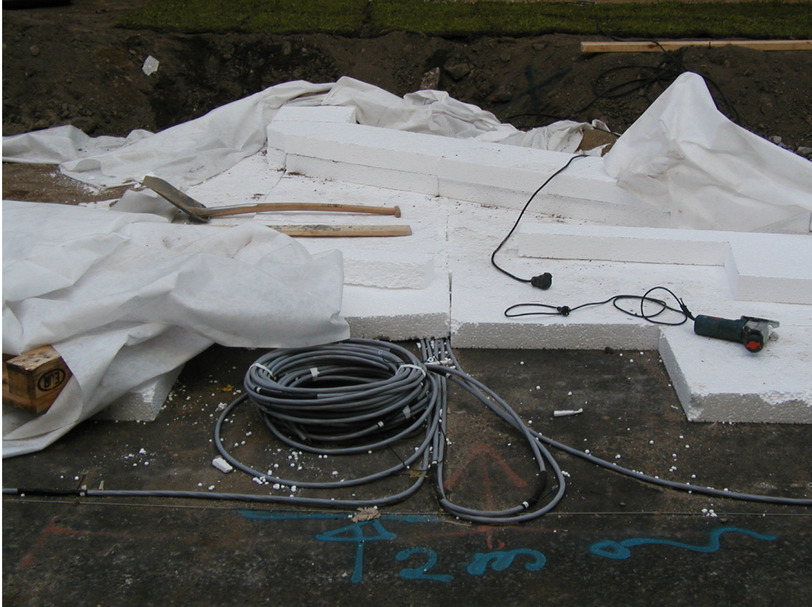
Figur 6 Installationen täcks över med cellplastblock
